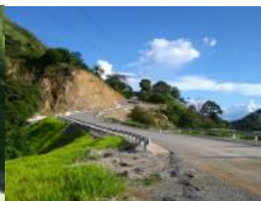
Señalización Corredor Coyaima - Ataco
