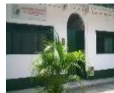
Mejoramiento Infraestructura ET Luis Carlos Galán Sarmiento – Honda
